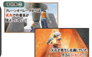
クレーンオペレータからは死角で作業員が見えていない!!
